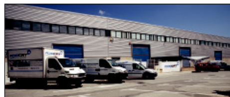
Detalle exterior instalaciones ADOCAT
